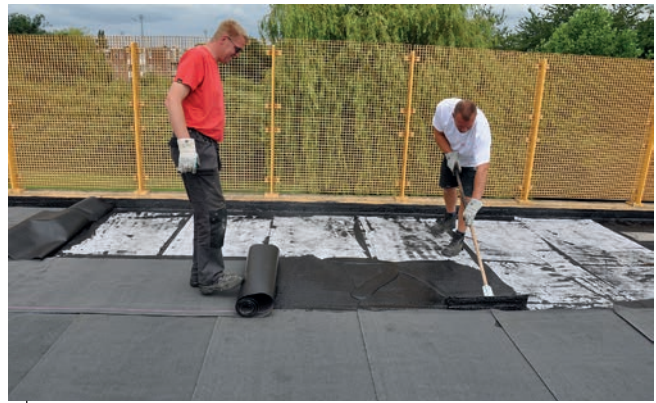
Ook de toplaag wordt in de warme kleefstof gerold.
