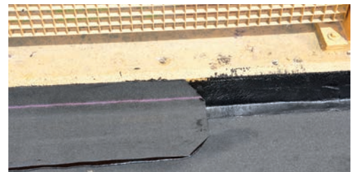
De tweede randstrook wordt opgezet tot bovenkant opstand.
