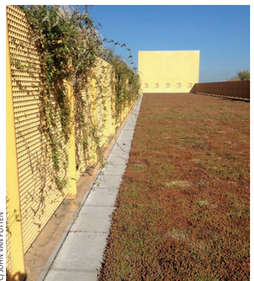
Het dak met de sedummatten.
