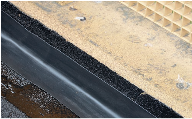
In de kimmén is een gewapende EPDM-strook gekleefd met de warme kleefstof.
